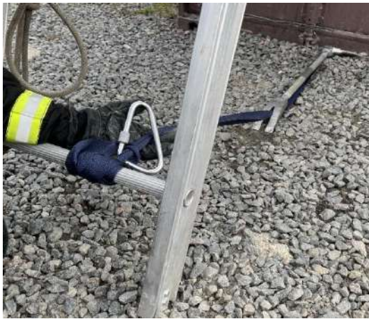
Рисунок 3 – Фиксация выдвижной трёхколенной лестницы (Л-ЗК) при помощи лома «Хулиган»
