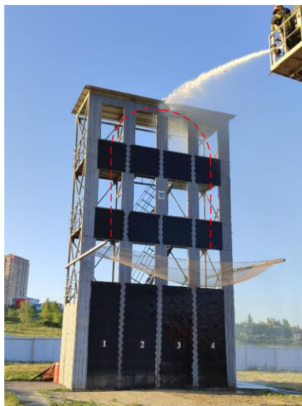
Рисунок 3 – Подача воды пожарным стволом РСКУ-70А с расходом 9 л/с
