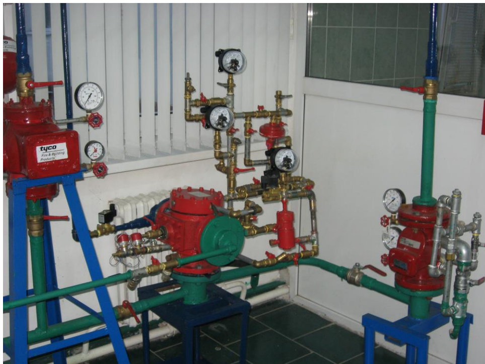
Рисунок 3. Внешний вид двухсекционного клапана
