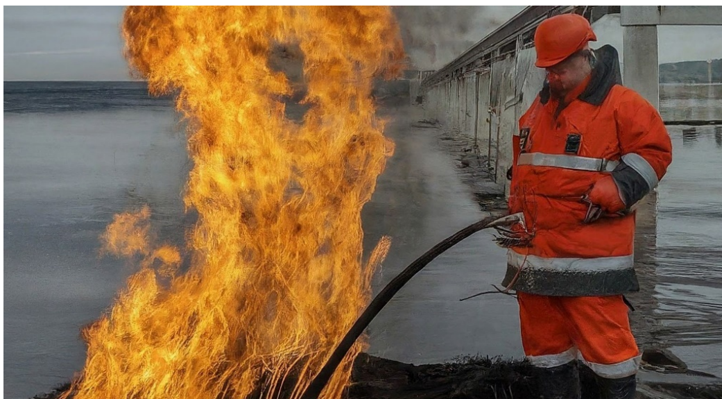
Рисунок 2. - Термический способ ликвидации нефти ООО «Композит»
