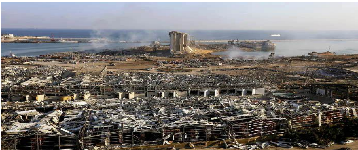
Рисунок 1. – Разрушения после взрыва в порту Бейрута
