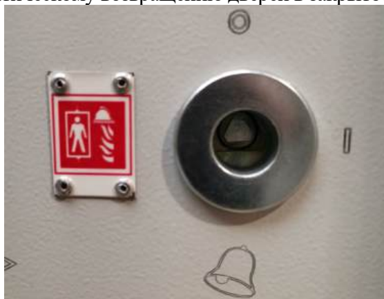
Рисунок 1. – Гнездо для ключа, включающего режим перевозки пожарных подразделений
