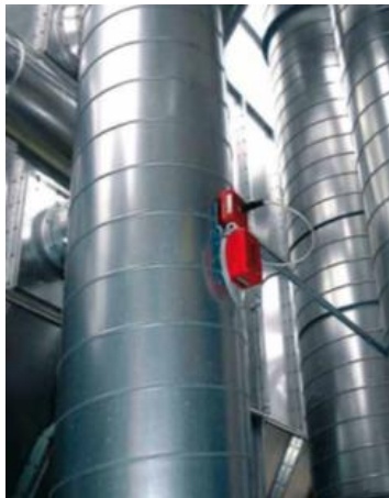
Рисунок 4 – Применение системы искрогашения в пылевых (аспирационных) трубопроводах
