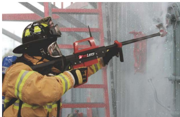
б – подача огнетушащих веществ через стену установкой Gyrolance
