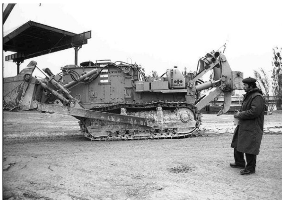
Рис. 3 — Японское чудо техники – бульдозер "Komatsu" с дистанционным управлением
