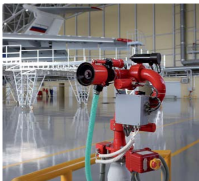
Рисунок 1. – Внешний вид роботизированных установок пожаротушения.
