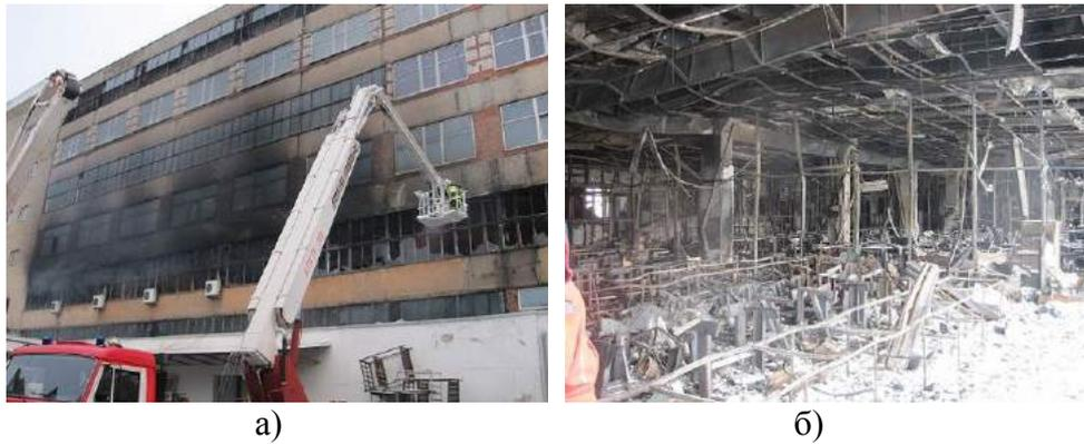
Рис. 1. Процесс ликвидации пожара (а) и последствия, вызванные пожаром производственных и складских помещений швейного предприятия (б)
