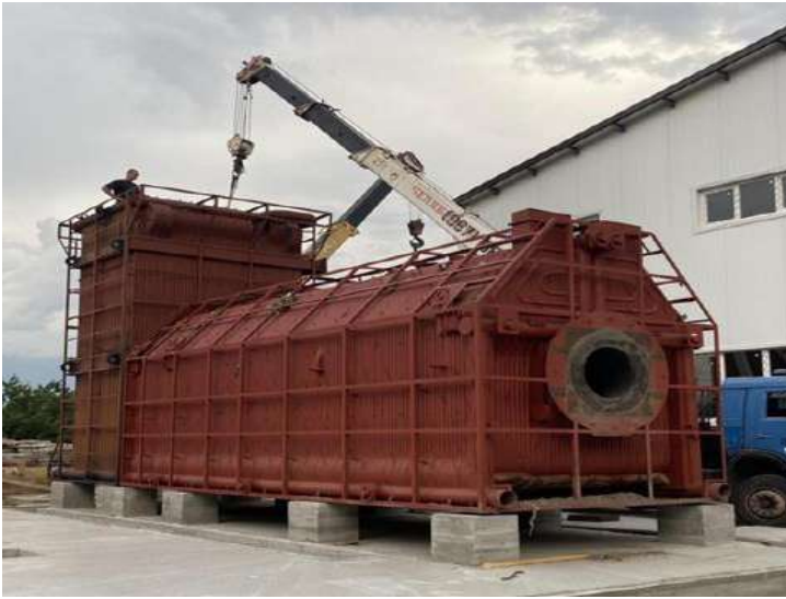
Рисунок 1. Внешний вид котла водогрейного КВ-ГМ-30-150
