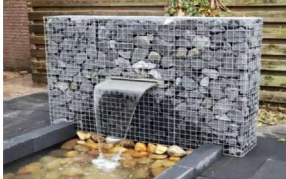
Bild 2. Kleiner Wasserfall, eingebaut in eine Gabione [2]
