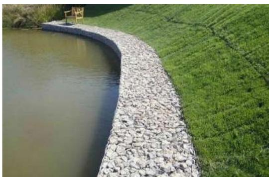
Bild 1. Gabionenstruktur zum UferschutzReservoir vor Erosion [1]
