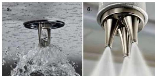
Рисунок 1. Инженерные противопожарные установки: а) сплинклерные системы пожаротушения (ССП); б) дренчерные системы пожаротушения (ДСП).
