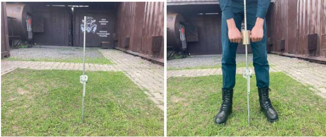
**Рисунок 4. – Техника вбития заземляющего штыря в грунт**
