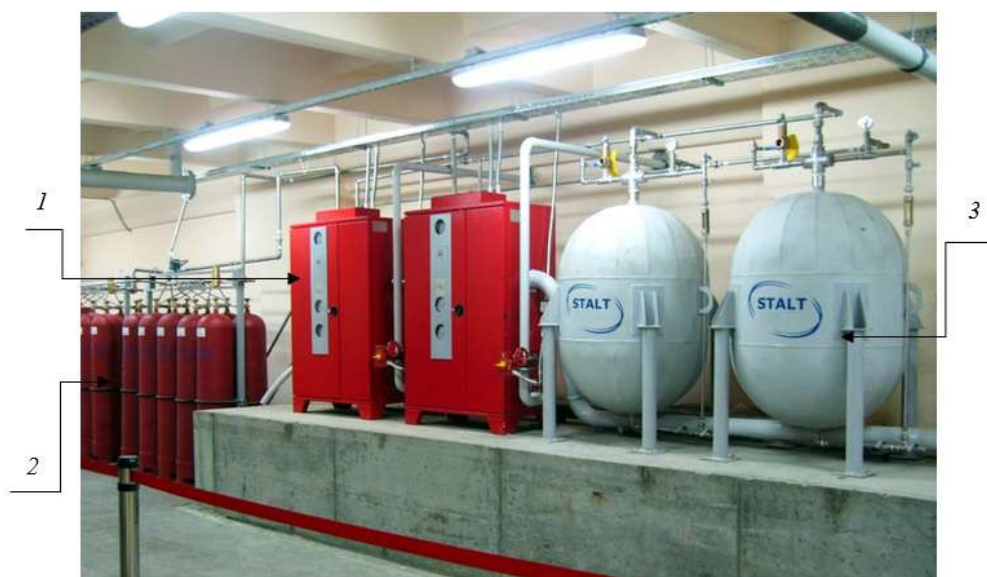
1 – пеногенерирующее устройство; 2 – баллоны со сжатым воздухом; 3 – бак для пенообразователя
