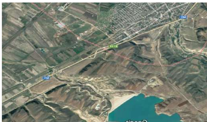
Рис. 1 – Плотина Тахтакорпюнского водохранилища
