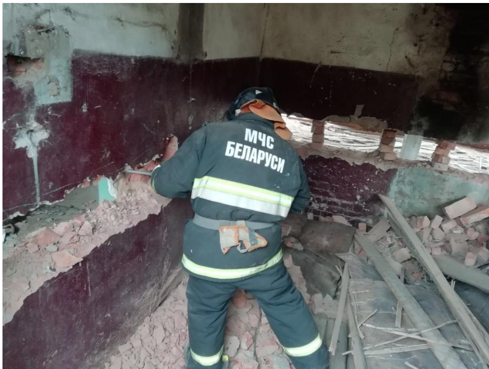
Рисунок 2. - Общий вид ниш в стенах и пример работы взрывника по их подготовке
