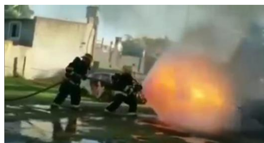
Рисунок 2 – Ликвидация горения разгерметизированной установки на объекте нефтегазовой отрасли при помощи ручного ствола
