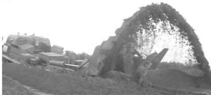
Рисунок. Общий вид котлованной машины МДК-3 в процессе работы
