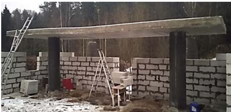
Рисунок 2. – Общий вид железобетонного фрагмента каркаса
