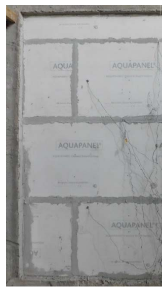
в – фрагмент перегородки с обработкой стыков
