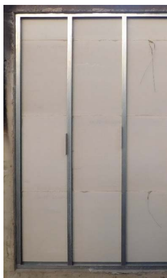
a – вид металлического каркаса перегородки
