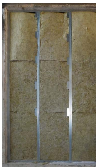
б – заполнение полости минерватным утеплителем
