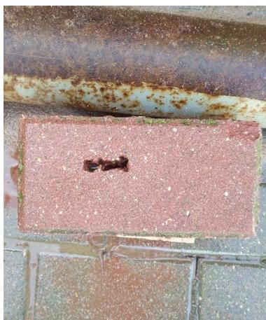
*б* – тротуарная плитка «Кирпичик» высотой 80 мм
