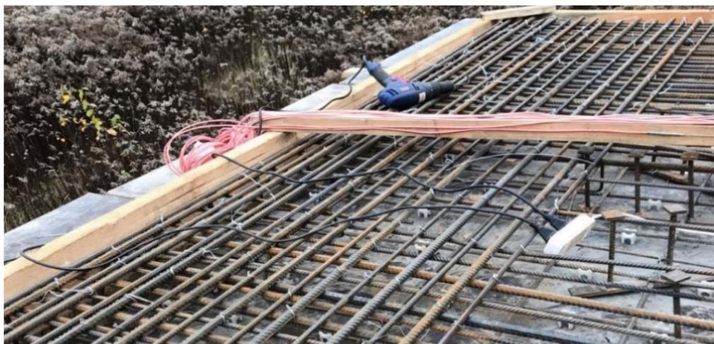
**Рисунок 10. – Процесс установки верхнего ряда арматуры монолитного перекрытия экспериментального фрагмента**
