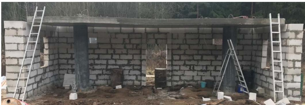
Рисунок 12. – Процесс возведения ограждающих конструкций фрагмента каркасного здания
