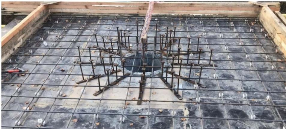
**Рисунок 9. – Армирование опорных участков монолитного перекрытия экспериментального фрагмента**
