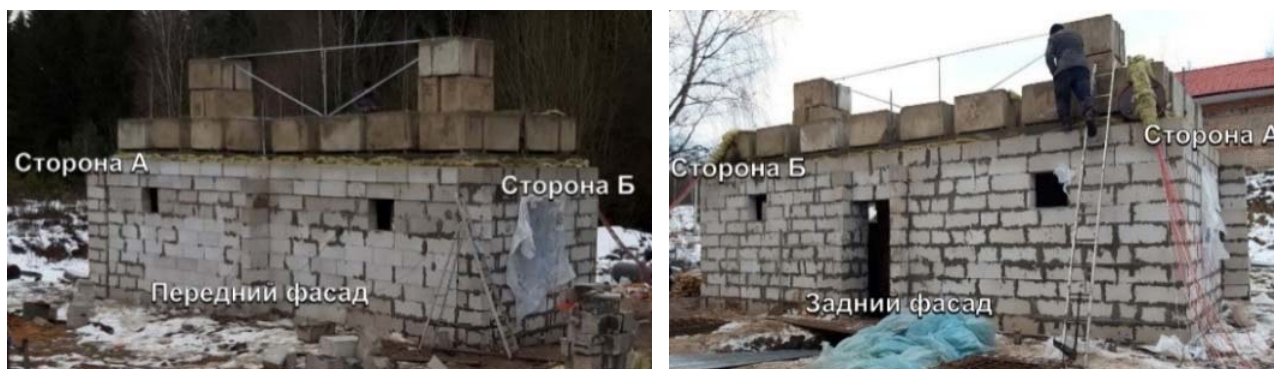
Рисунок 1. – Общий вид испытательного фрагмента каркасного здания
