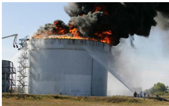
Рисунок 1. – Тушение пожаров в резервуарах от передвижной пожарной техники
