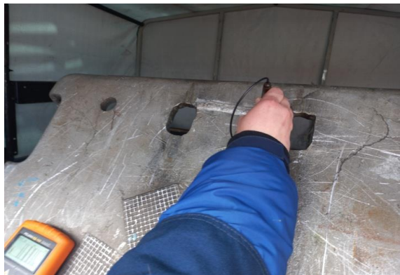
б – в зоне сварного шва и зоне термического влияния между двумя отверстиями, служащими для фиксации пирамиды в верхнем поднятом положении
