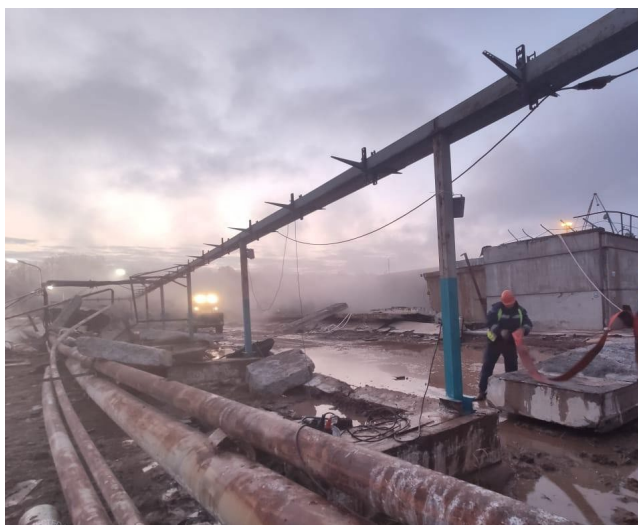
Рисунок 2. – Последствия разрушения резервуара со стоками производства
