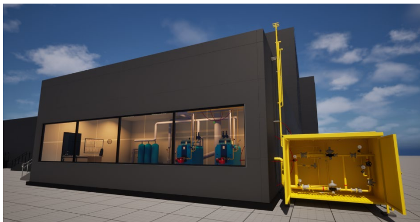
б – котельная, пристроенная к пожарному отсеку № 3
