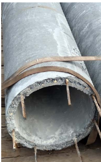
Рисунок 1. – Моделируемая центрифугированная железобетонная колонна
