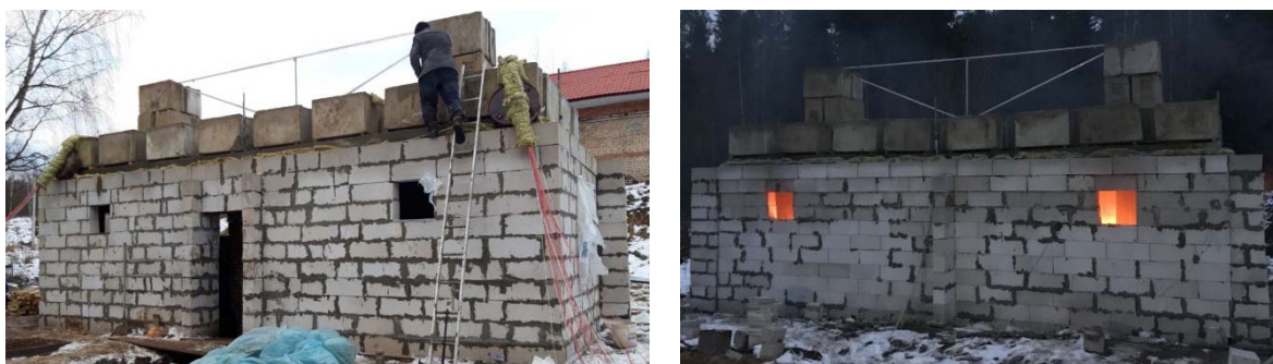
Рисунок 1. – Испытанный фрагмент здания (главный и задний фасады)
