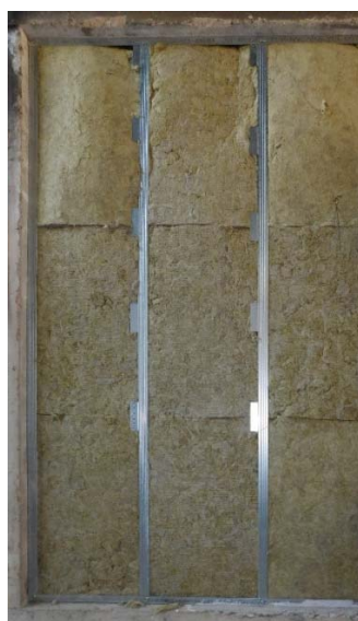
б – заполнение полости минерватным утеплителем
