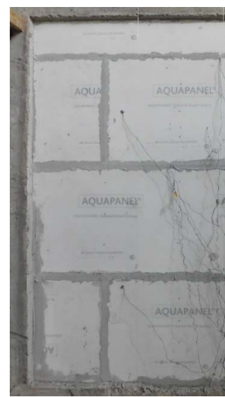
в – фрагмент перегородки с обработкой стыков
