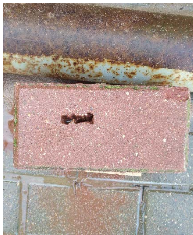
б – тротуарная плитка «Кирпичик» высотой 80 мм
