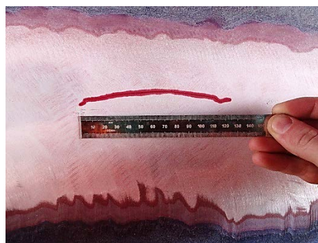
б – измерение трещины
