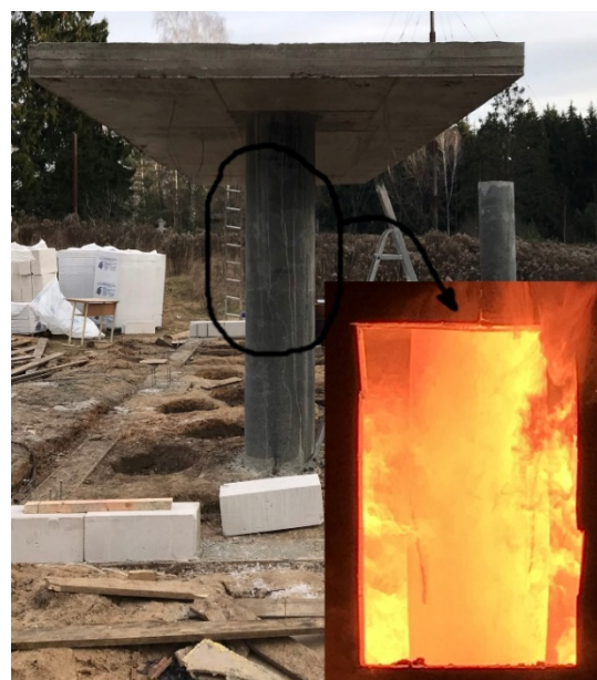
б – вид колонны II с торцевой стороны фрагмента (на этапе его возведения и на 67-й мин испытаний)
