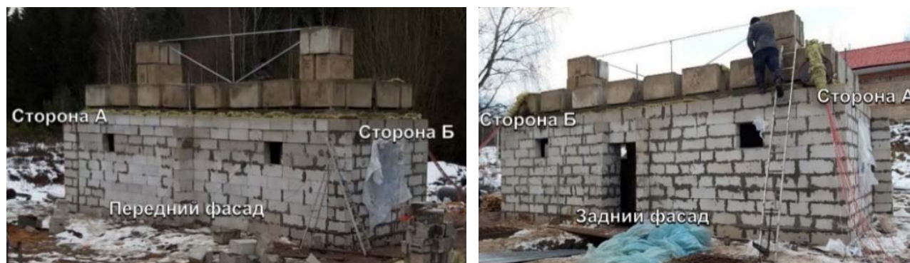
Рисунок 1. – Общий вид испытательного фрагмента каркасного здания
