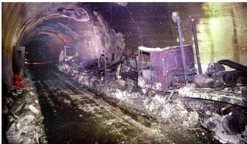
Рисунок 3. – Последствия взрыва грузовика в тоннеле под Монбланом
