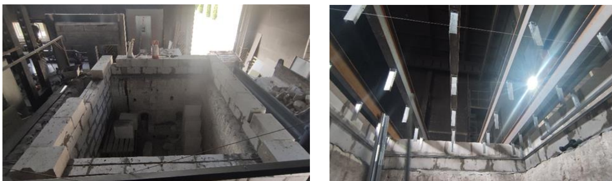
Рисунок 8. – Промежуточные результаты монтажа фрагмента огнестойкого подвесного потолка с применением гипсовых негорючих плит
