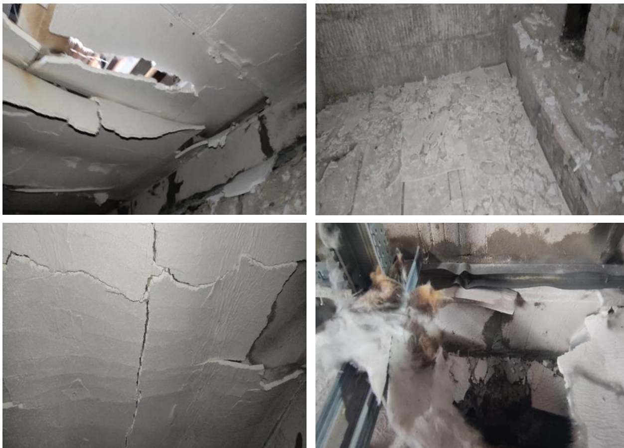
Рисунок 14. – Огневая камера печи после проведения испытаний. Локальное разрушение гипсовых негорючих плит, деформация направляющего профиля
