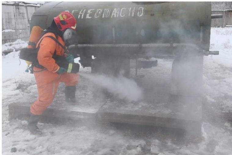
Рисунок 9. – Использование РГТ-800 при аварийных разливах нефтепродуктов
