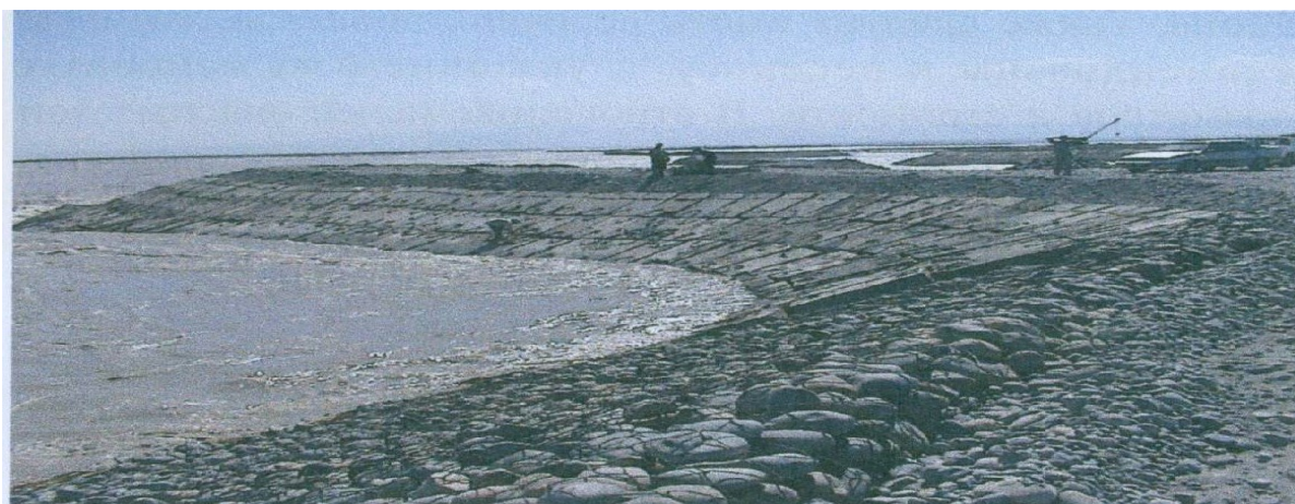
Рисунок 4. – Укрепления дамб и шпор с использованием бетона и габионов
