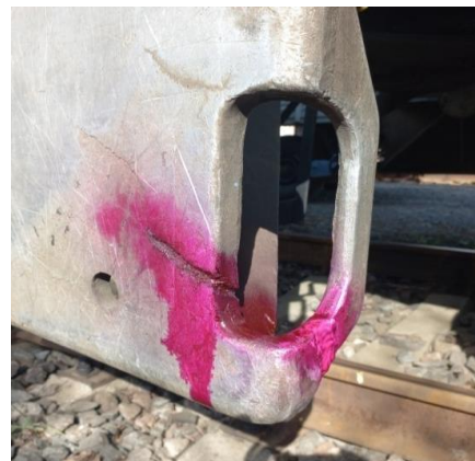
в – сварной шов рукоятки и глубокий концентратор в виде вырыва
