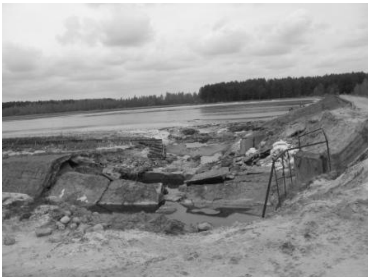
Рисунок 4 – Берегозащитные сооружения и конструкции автоматического водосброса Княжеборского водохранилища
