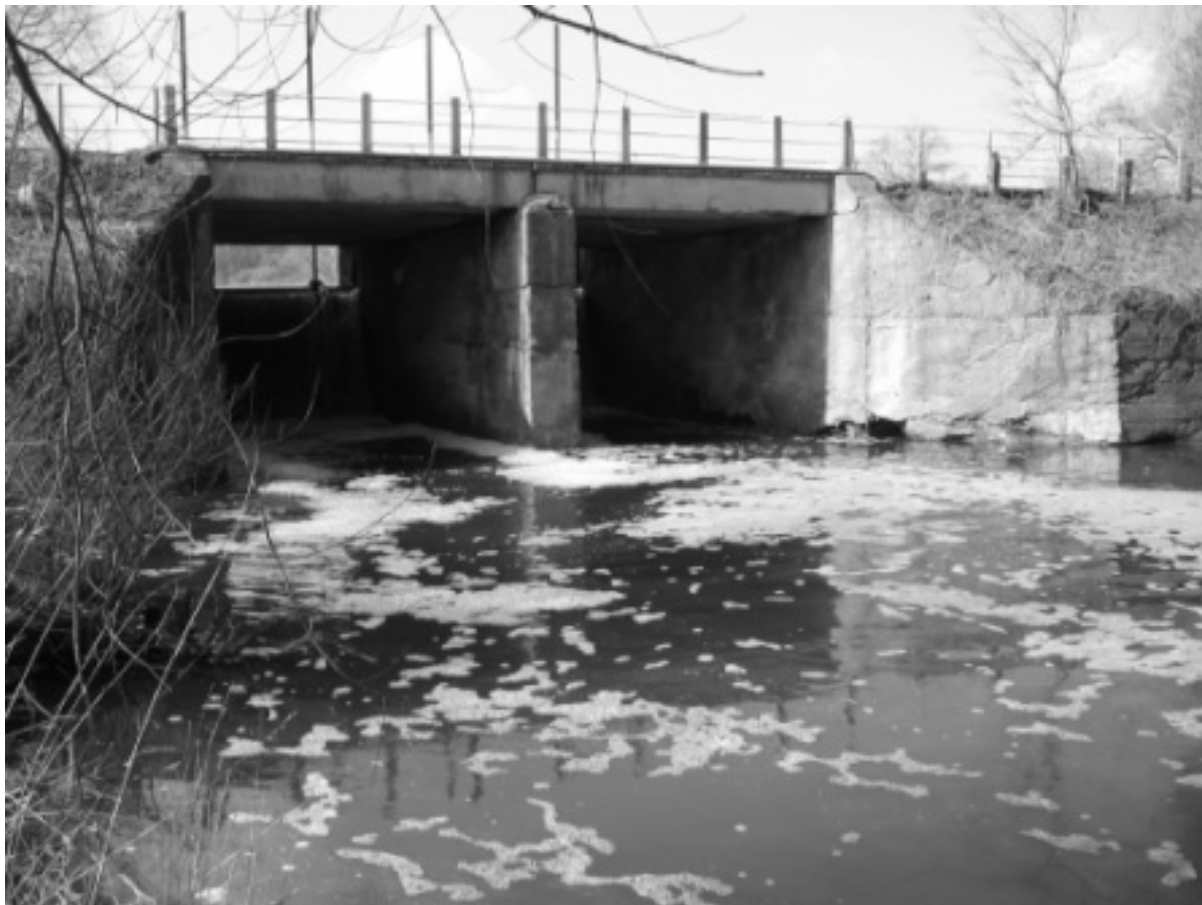
Рисунок 5 – Железобетонный водосброс водохранилища Острошицкий Городок
