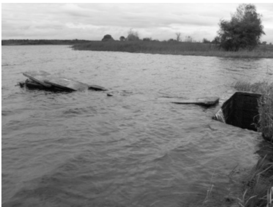
Рисунок 3 – Шахтный водосброс водохранилища Лаздуны
