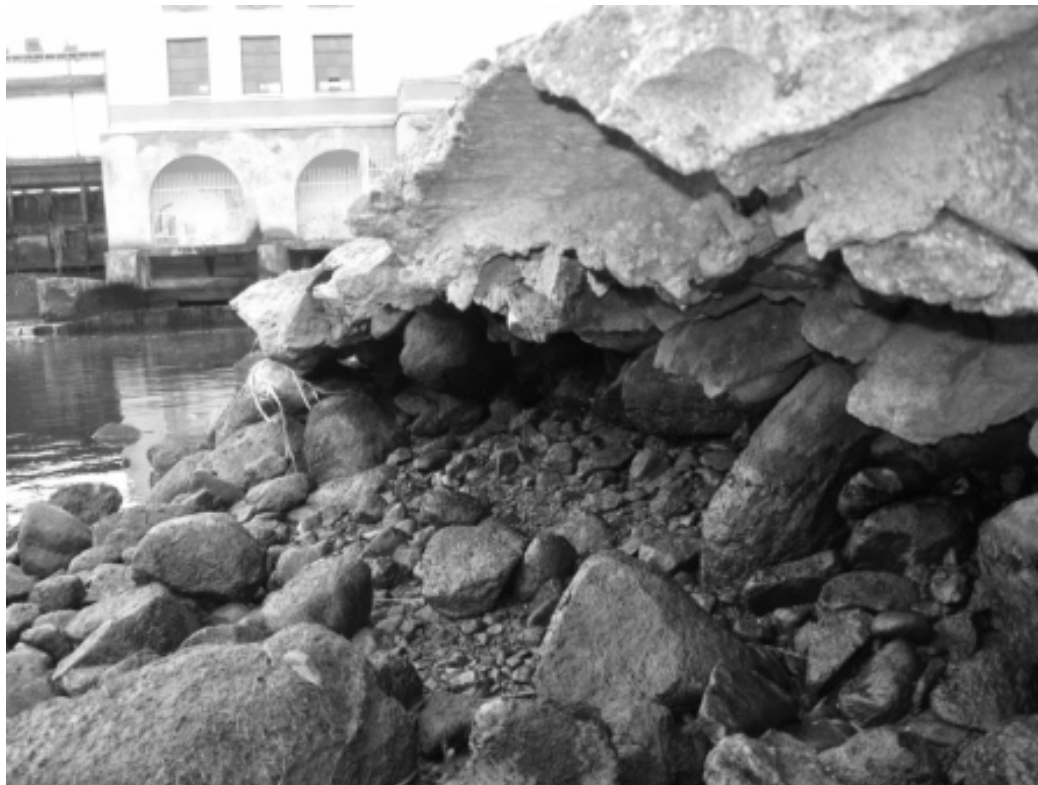
Рисунок 2 – Берегозащита в нижнем бьефе ГЭС Волпа
