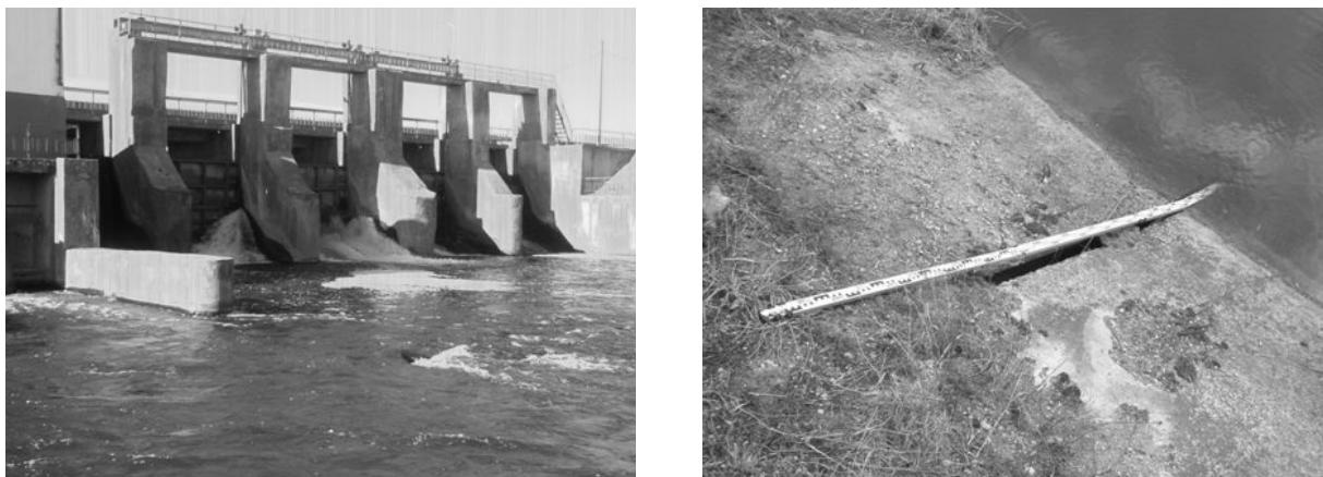
Рисунок 1 – Примеры аварийной эксплуатации ГТС
