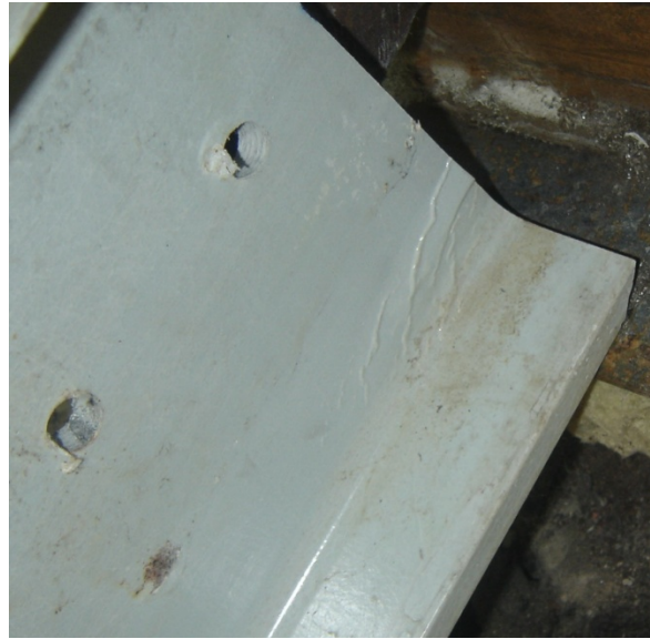
Рисунок 7 – Вид узла опирания балки после испытаний
